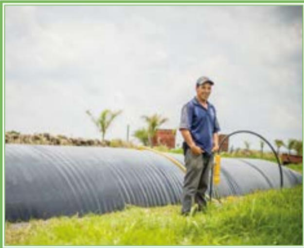
te los desechos de las granjas. Dentro de la membrana, los desechos combinados con agua se fermentan en un ambiente libre de oxígeno para producir biogás y biofertilizante, un potente fertilizante orgánico y excelente regenerador de suelos.
